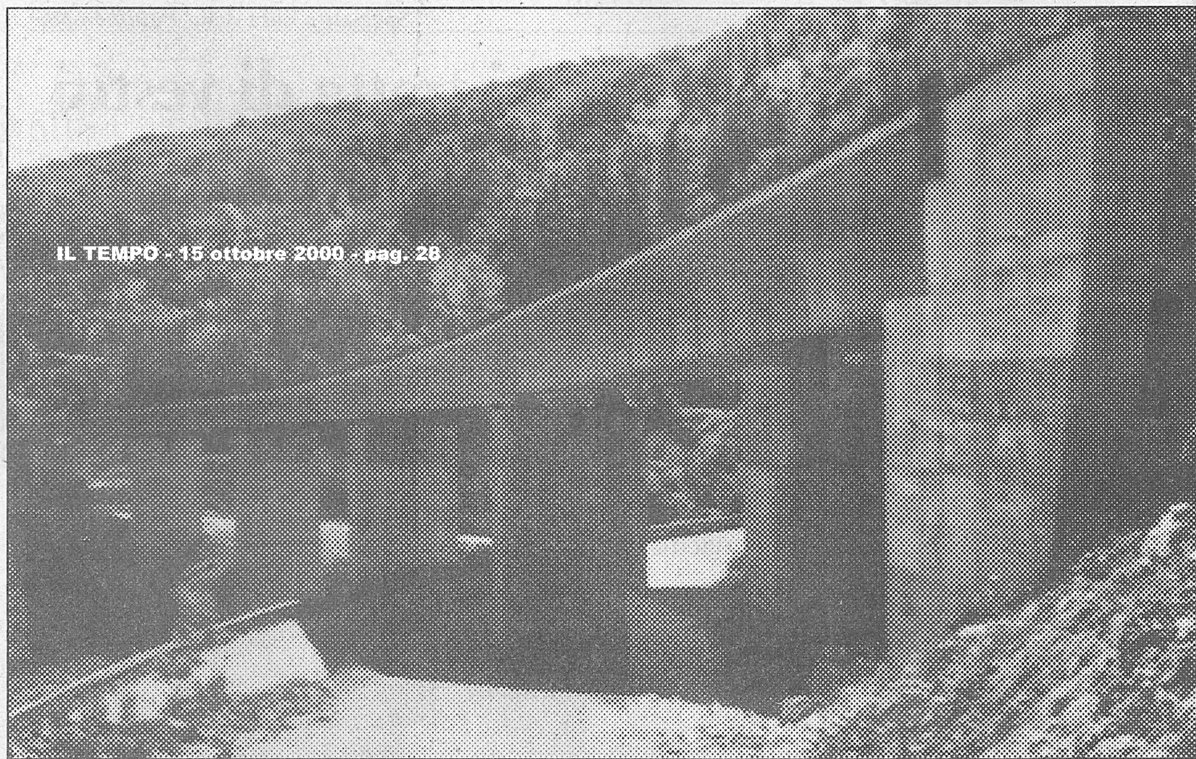
Un ponte in costruzione lungo la superstrada delle polemiche
